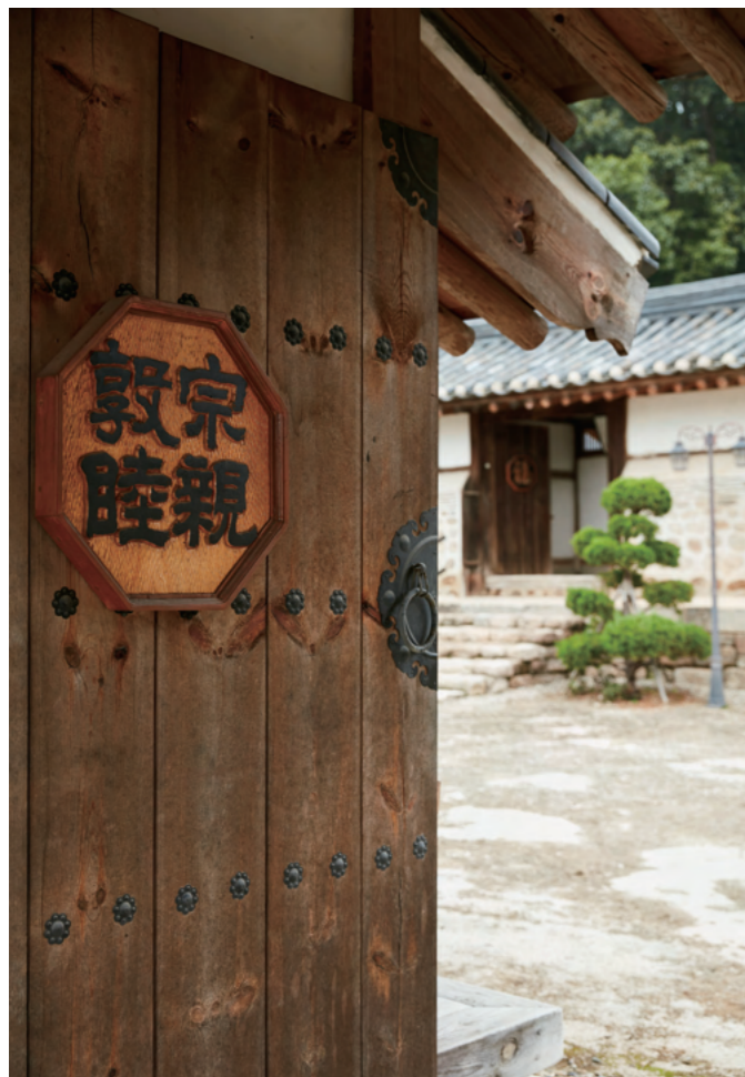
위치 : 경기도 여주시 점동면 모래실2길 11 자유 관람. 내부 방문은 사전 협의 문의 : 여주시청 문화재관리팀
